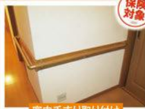
室内手すり取り付け
