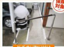
外手すり取り付け
